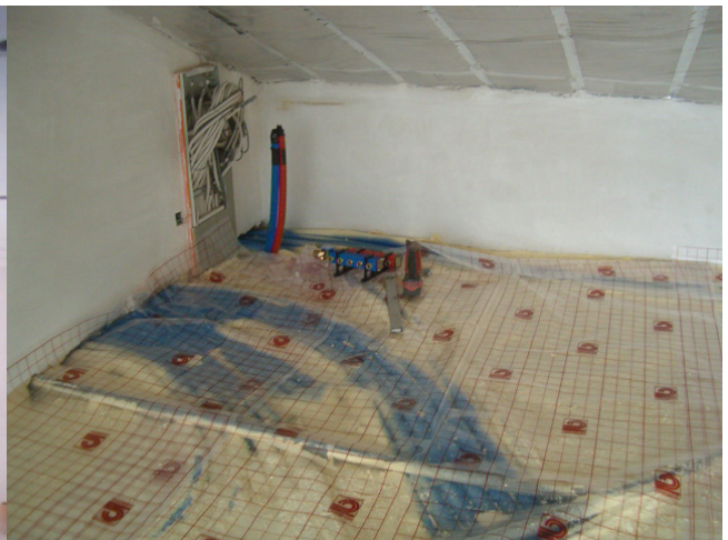
Foto: Indien de ventilatieleidingen in opbouw geplaatst worden bovenop de vloer dan verhoogt dit de vloeropbouw en verlaagt dit de vrije hoogte van de ruimte. Te vermijden is een opeenstapeling van leidingen zoals daar zijn: sanitaire en regenwaterafvoeren, leidingen van (vloerverwarming of sanitaire) collectoren, elektriciteits- en ventilatieleidingen, allerhande wachtbuizen.
