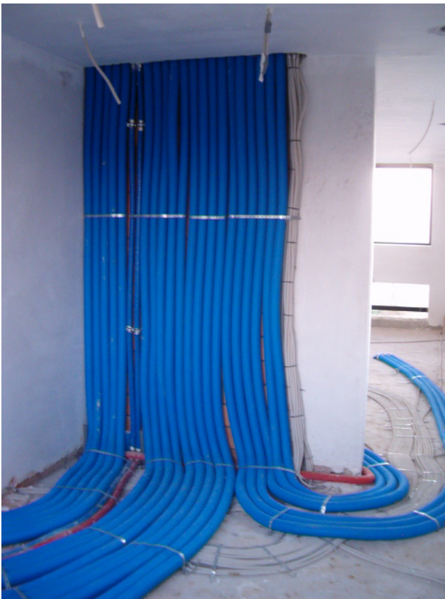
Foto: Indien de ventilatieleidingen in opbouw geplaatst worden bovenop de vloer dan verhoogt dit de vloeropbouw en verlaagt dit de vrije hoogte van de ruimte. Te vermijden is een opeenstapeling van leidingen zoals daar zijn: sanitaire en regenwaterafvoeren, leidingen van (vloerverwarming of sanitaire) collectoren, elektriciteits- en ventilatieleidingen, allerhande wachtbuizen.
