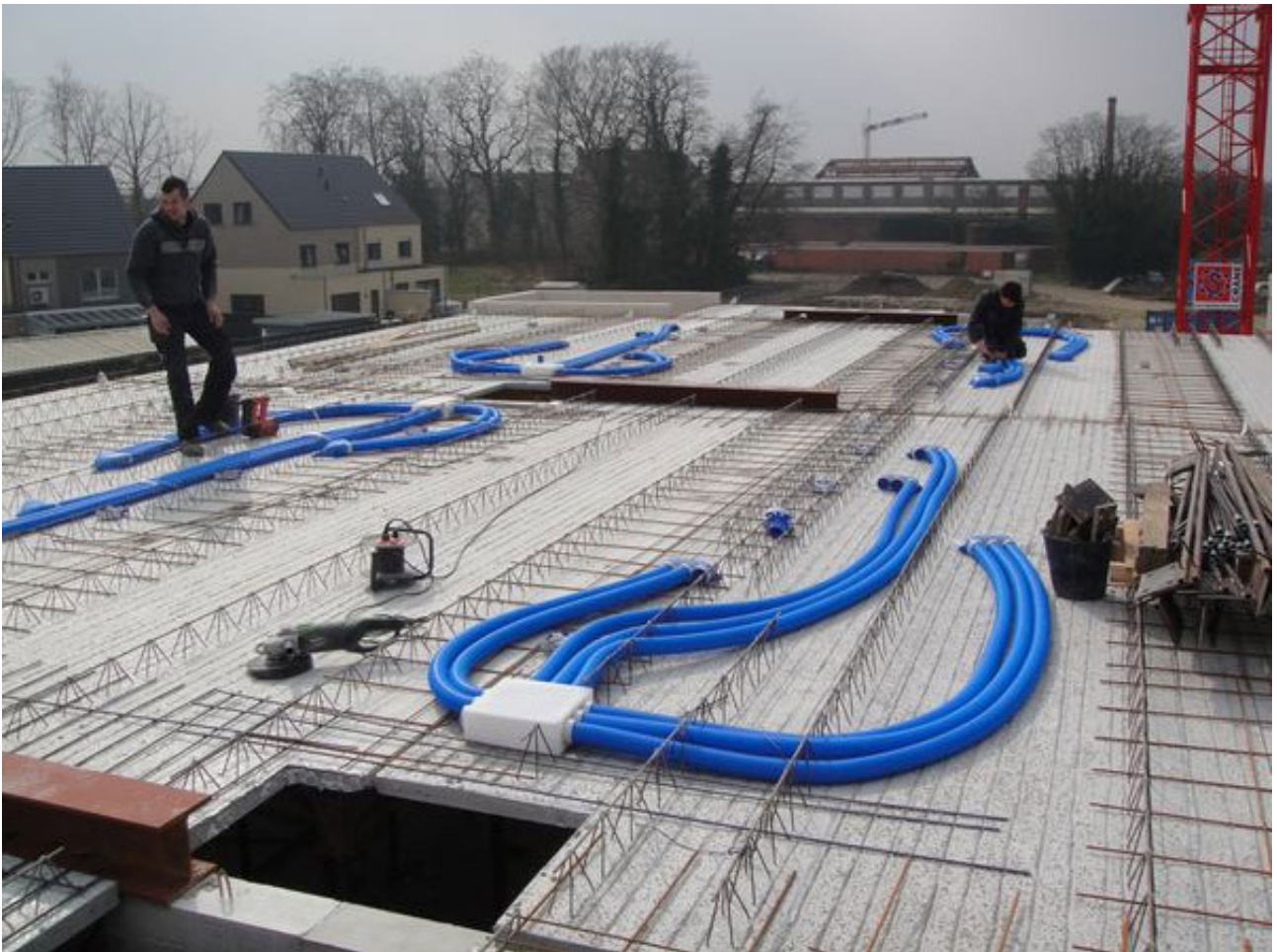
Foto: Idealiter worden de ventilatieleidingen verwerkt in de predallen. Interactie vereist tussen: architect - stabiliteitsingenieur - installateur ventilatie.
